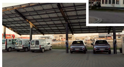
Die neue Firmenzentrale von ITF-SYSTEMHAUS in Burgkirchen
